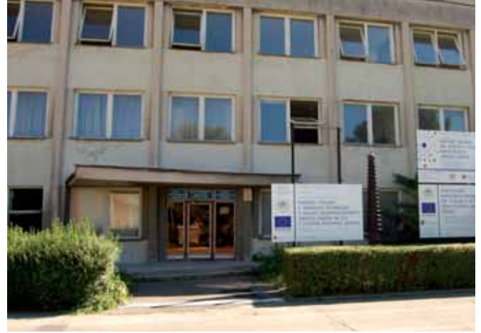
Budova v Trnávke sa stavala v rokoch 1964 – 1968. Využíva ju Katedra elektroenergetiky a Katedra elektrotechnológie FEI na pedagogickú činnosť a výskum zameraný na zvyšovanie spoľahlivosti elektroenergetických zariadení najmä diagnostikou vysokonapäťovej izolácie.
